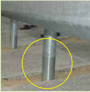
ガードレール支柱地際部
