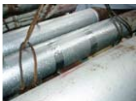
①配管吊り上げ
