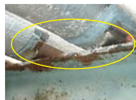
⑤施工完了
