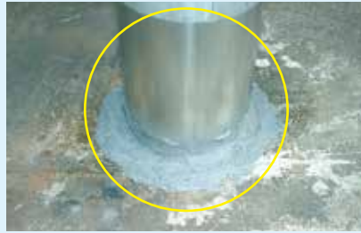
鋼製支柱地際
