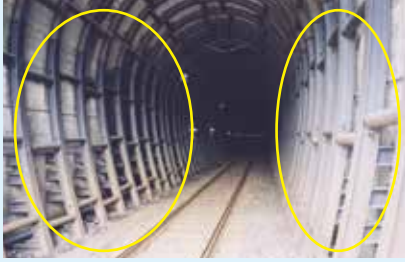
トンネル内H鋼全て
