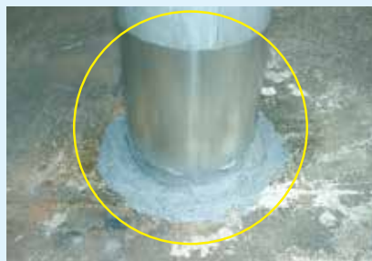
鋼製支柱地際
